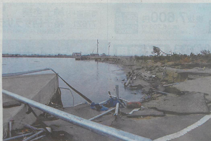
東日本大震災での津波で損壊した閑上ヨットハーバー—県セーリング連盟提供
